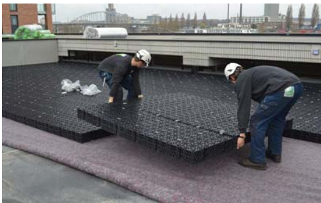
Hier: Verlegung werkseitig vormontierter Großflächensegmente (so nur bei WRB 85i möglich)
